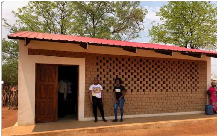
Abbildung 4 Speise- und Aufenthaltsraum
